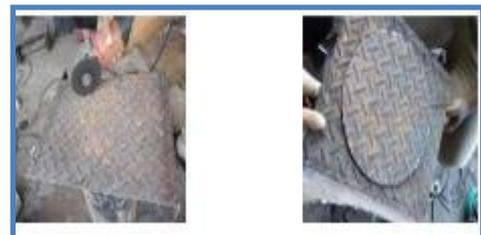
Gambar 7. Pemotongan tutup Hopper dan hasil potongan
