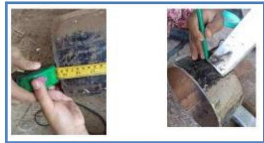
Gambar 5. Mengukur dan membuat sket pada pipa
